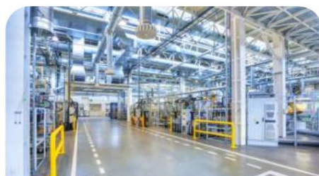
工業的 檢查組件/設備
